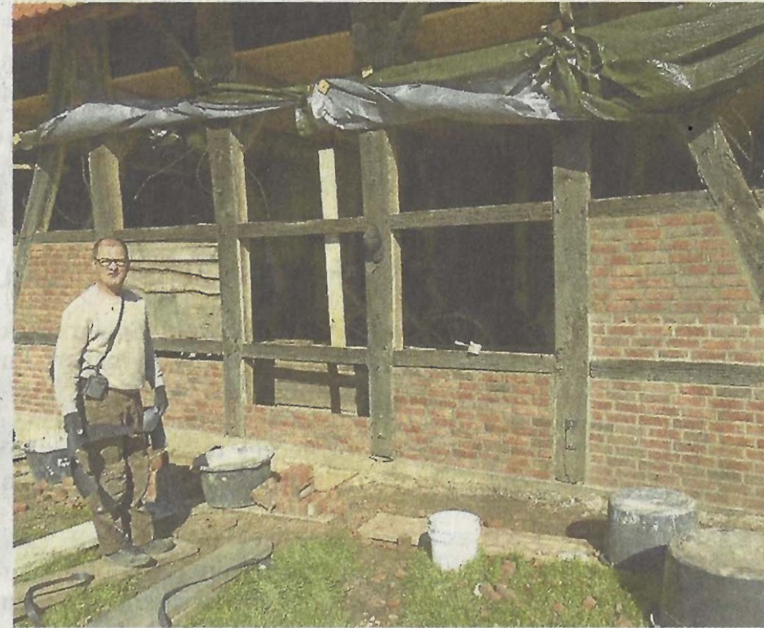
Momentan laufen die Mauerarbeiten an der Heimatscheune in Gahlen.
